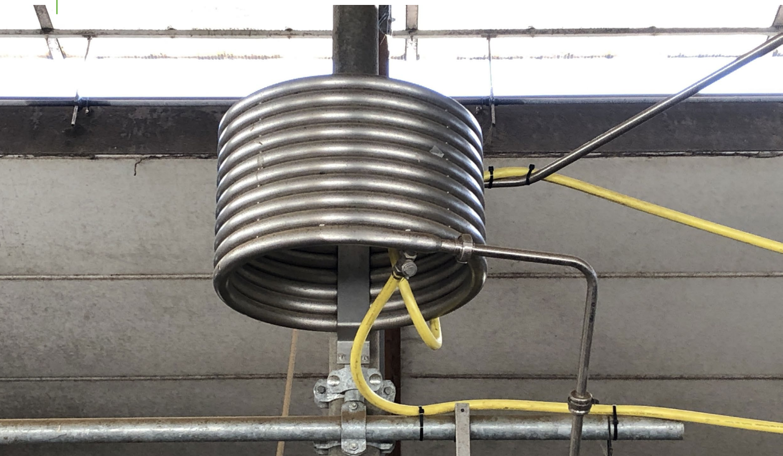
Energie sparen durch Milchvorkühler
