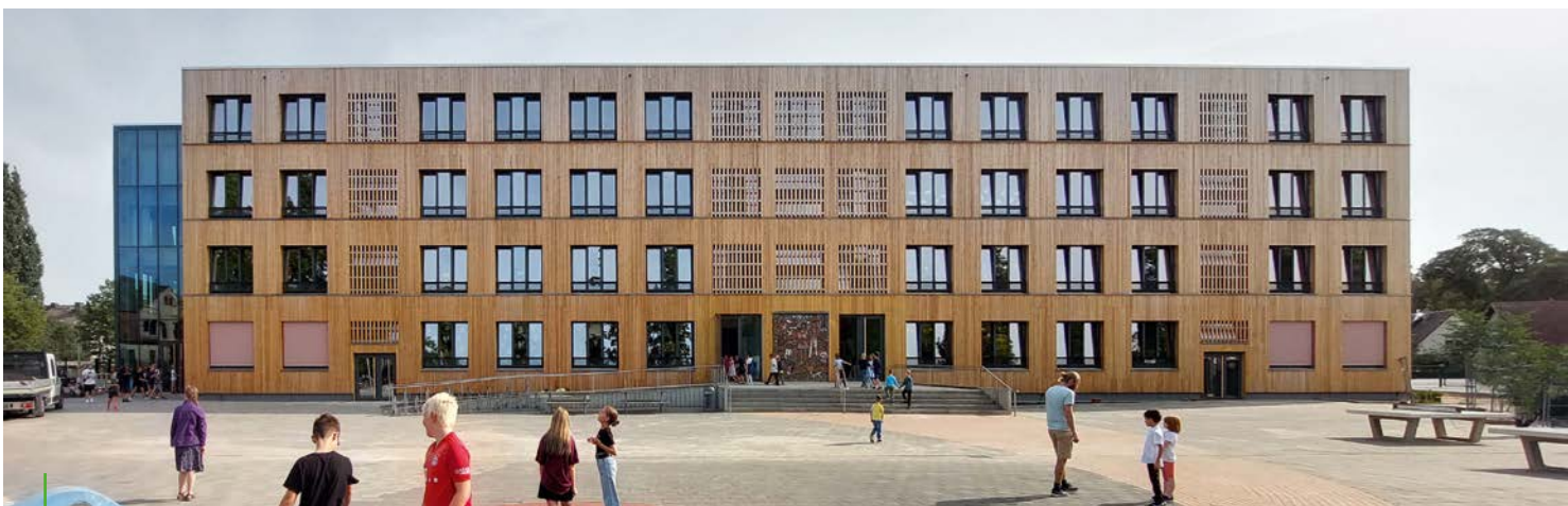
Mitte: Foyer und Flur Bestand | Unten: Fassade Schulhof / Fotos: CKRS Architekten
